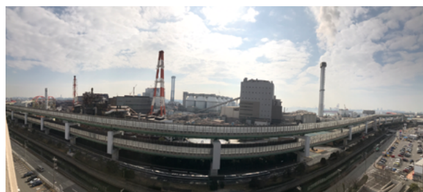
発電所の建設予定地 建設前の様子 (撮影：神戸製鋼火力発電所事件原告)
