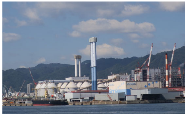
神戸発電所（神戸製鋼・関電） 大市街地に増設
