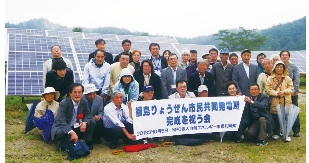
2013年9月に50kWの太陽光発電を福島県伊達市に設置。
