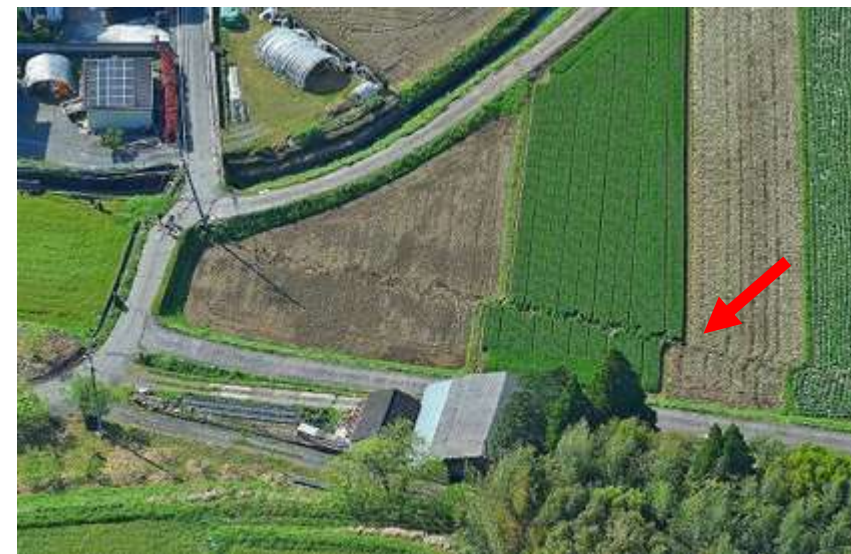
2016年 熊本地震で畑地に180mにわたり 表出した地表地震断層(最大2.5m)、上益城 郡益城町上陳821 熊本地震ミュージアム記憶の廻廊 https://kumamotojishin-museum.com/remains/detail/27
