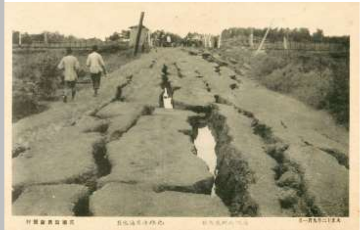
1923年 関東大震災 館山北條海岸通地裂
