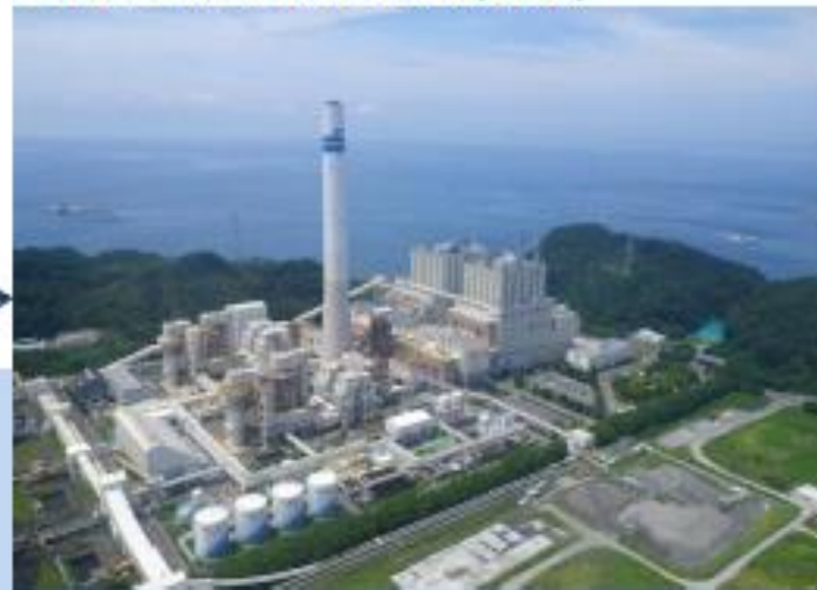
長崎県 松島火力発電所(現在)
