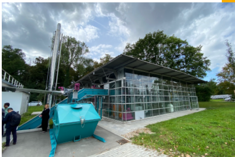
施設に隣接する自治体が運営する学校と、105km のパイプラインを整備して周辺地域 140 軒への熱供給を行う。熱源は、70% 程度が木質チップ、10% が太陽熱、残りがバイオガス、天然ガスとなっている
