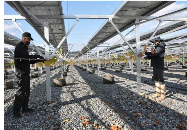
陸前高田しみんエネルギーが12月から余剰電気を購入するブドウ棚に設置されたソーラーシェアリング
